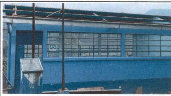
Foto 2: Sustitución de capotes lámina por lámina troquelada. En dos aulas de primaria.
