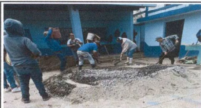
Foto 10. Reparación de planchas de concreto de patio ( 8 cm de grosor)
