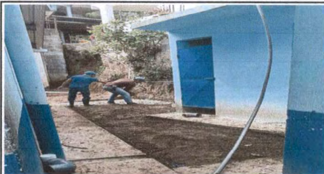
Foto 8. Sustitución de tubería PVC línea principal de aguas negras.
