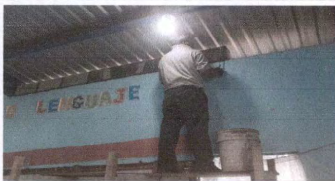
Foto 13: Reparación de paredes (sellado de aula pequeña.)
