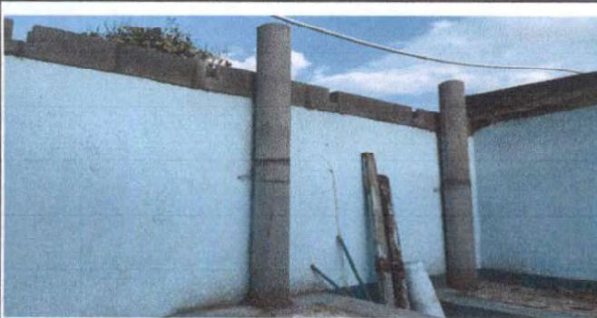
Foto 3: Sustitución de estructura de soporte de madera por metal en techo de cocina.
