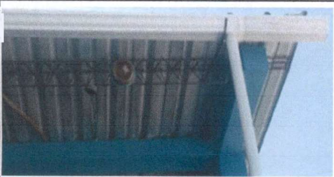
Foto 5: Sustitución de canal y bajada de agua pluvial en segundo nivel.
