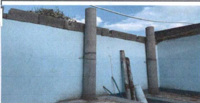
Foto 11. Sustitución de chimeneas de concreto.
