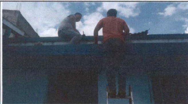
Foto1: Sustitución de lámina por lámina aluzinc 26 en techo de cocina.
